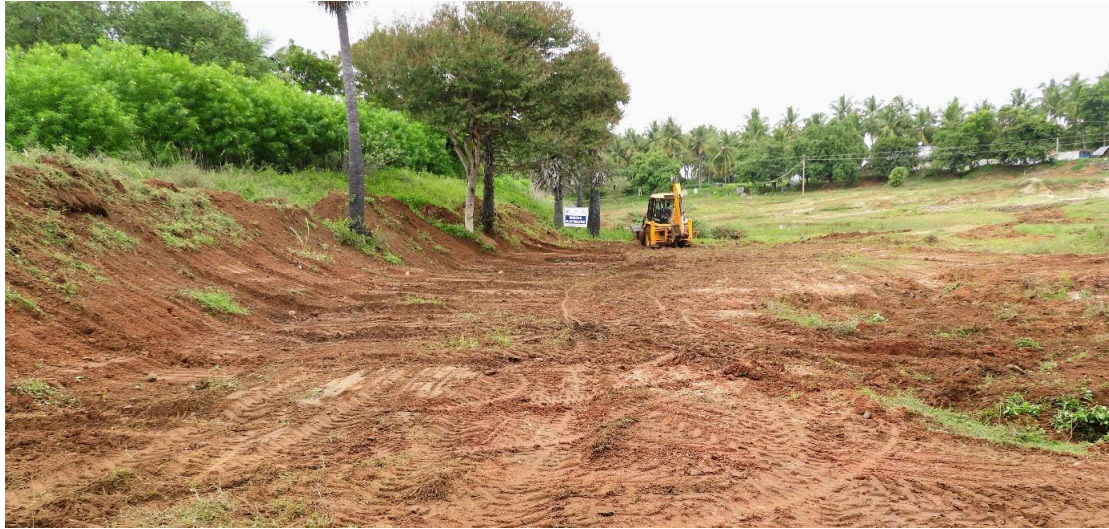
Travaux de réhabilitation du réservoir Pulichettikulam
