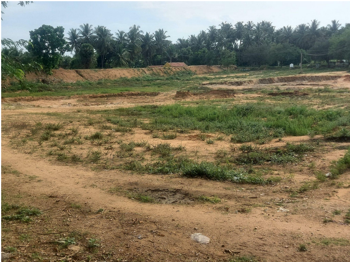
Réservoir Pulichettikulam après rénovation
